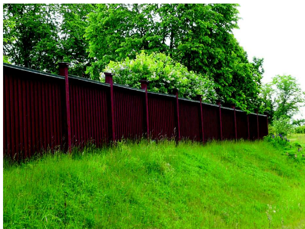
Kombination med vall och bullerskyddsplank.
