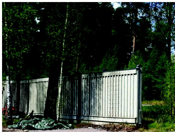
Exempel på bullerskyddsplank målat med grå slamfärg.
