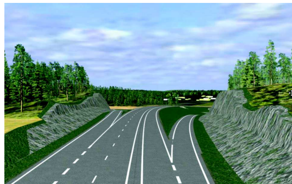
Bild från VR-modell. Bergskärning på båda sidor vid trafikplats Västra, km 5/200.
