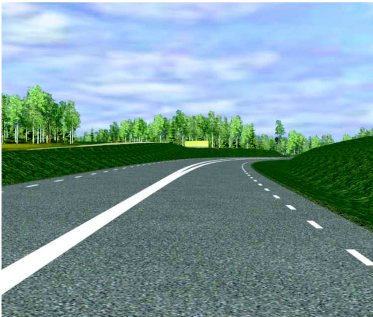
Bild från VR-modell. Skärgårdslänken i skärning för att uppnå önskvärd standard i plan och profil.
