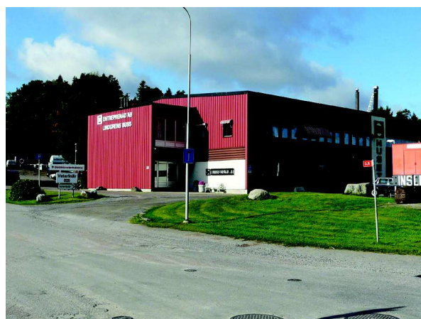
Verksamheter i SM-huset vid väg 210, km 7/200.
