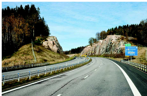
Exempel. Viltstängsel anpassas till terrängen för att orsaka liten visuell störning. Rätt placering i bilden till höger.
