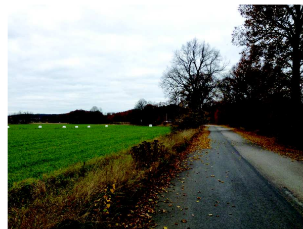
Stora lindar utmed väg söder om Göta kanal, km 7/600.
