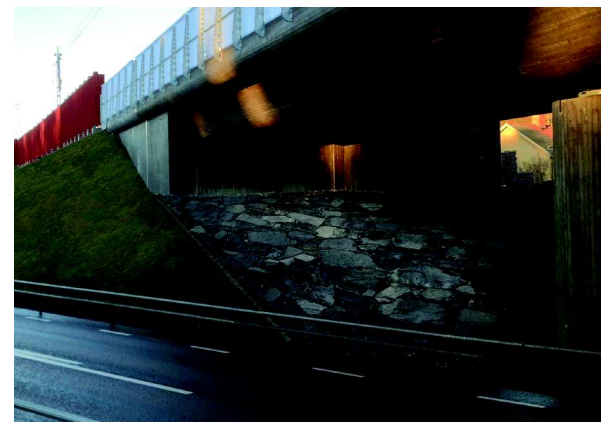
Exempel på ordnad fältsten som material under bro och kantbalk med rundad undersida.
