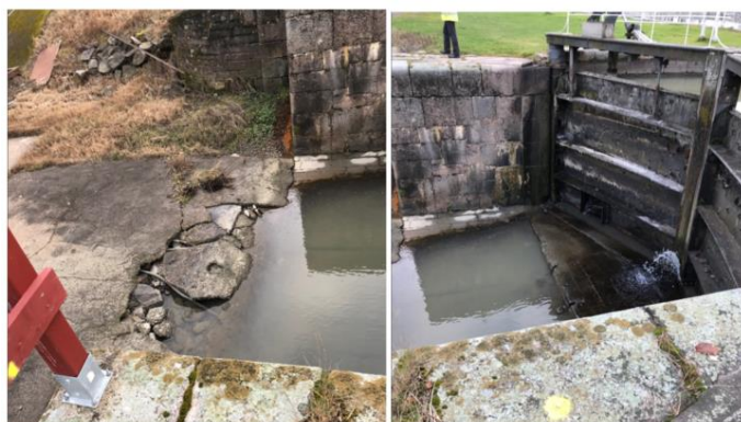
Figur 10 Torrdockans bottenplatta och sluss mot Göta kanal. Fotot taget 2021-11-16.
