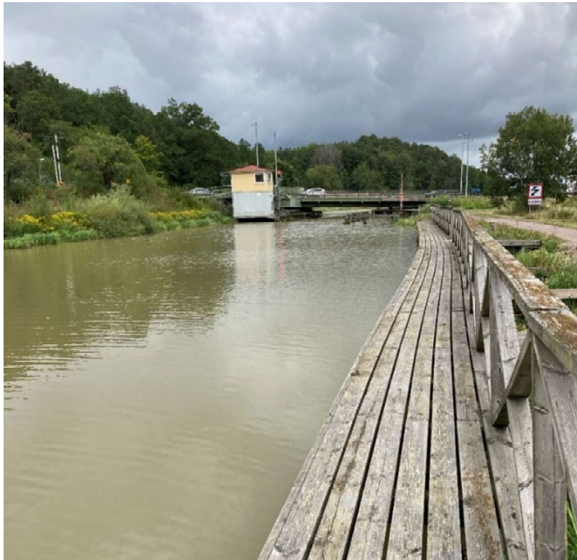
Figur 14. Foto på Göta kanal i läge där akvedukten planeras. Foto taget i östlig riktning mot befintlig öppningsbar bro vid platsbesök 2021-08-26 (fotograf: Sara Roth).
