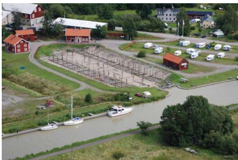
Figur 23. Klevbrinken med skeppsdockan från 1827, som är en av bara tre bevarade dockor utmed hela Göta kanal. (Foto: Svenska Gästhamnar 7 )
