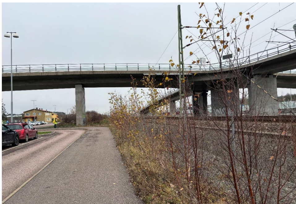
Figur 4.10.4–2. Vägbro över E45 och Norge/Vänerbanan.
