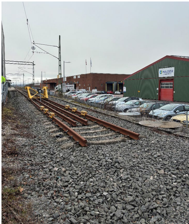
Figur 4.1–2. Slutet av spår 1 med stoppbock.
