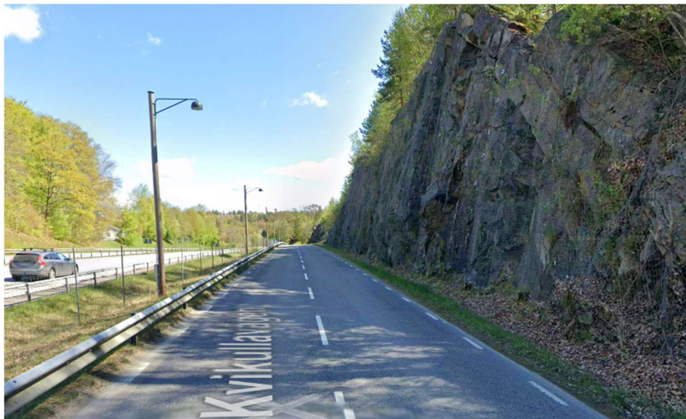
Figur 7. Belysningsstolpar utmed väg 1747. Google (2025), Street view-bild väg 1747/Kvikullavägen.
