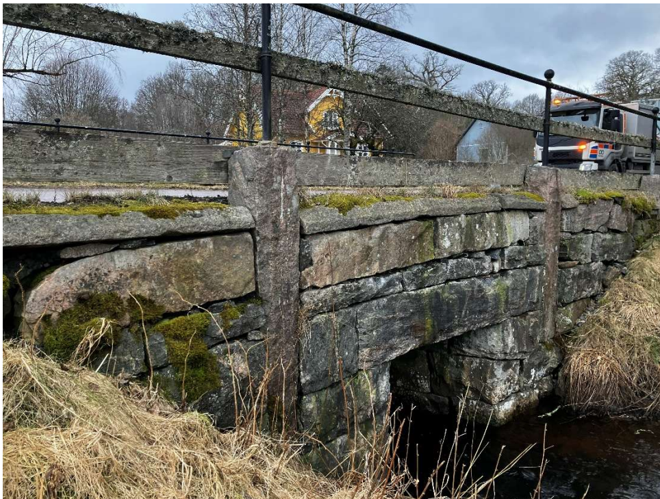
Figur 5. Befintlig stentrumma över Pliktån.
