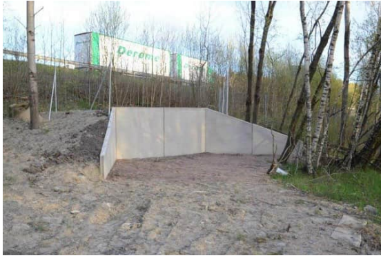
Figur 45. Exempelbild på ett enkelt utformat viltuthopp med sand nedanför. Viltstängsel ansluter mot uthoppet ett stabilt sätt. Fallhöjden är tillräcklig för att hindra fauna från att återigen ta sig in på vägbanan.
