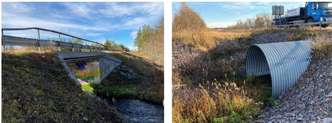
Figur 39. Befintliga byggnadsverken längs med sträckan. Till vänster bro över Luossajoki och till höger rörbro, vilken nyttjas som friluftsport.
