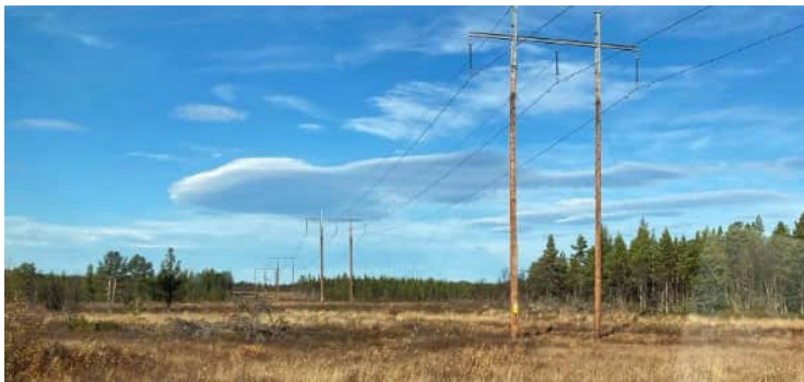
Figur 24. Kraftledningsgata som korsar E10. Vy norrut.
