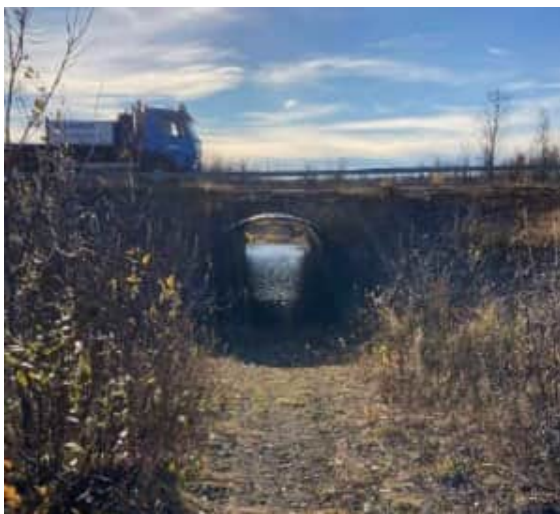
Figur 35. Rörbro / Port för det rörliga friluftslivet.
