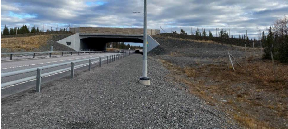
Figur 54. Befintlig faunabro vid Mertainen, mellan Svappavaara och Kauppinen. Faunaskydd, vilket skyddar mot bländning, har här placerats ovanpå bro. På nya faunabroar i projektet bör skyddet även följa rampen cirka 20–30 meter för att ytterligare skydda mot bländning.
