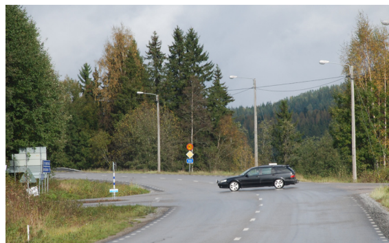
Figur 4.8. Korsningen med väg 320/631 som har dålig sikt och saknar vänstersvängfält är mycket olycksdrabbad.
