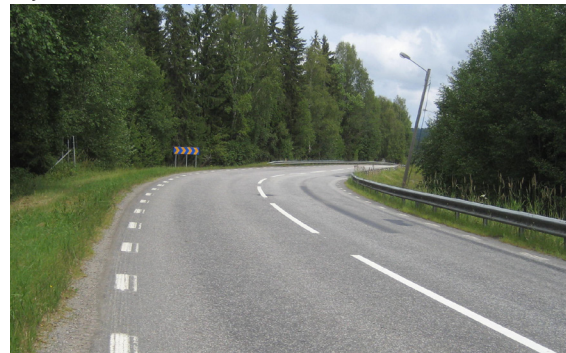
Figur 4.10. Vägens sidoområde har brister som branta slänter utan räcken och oeftergivliga föremål som träd och belysningsstolpar nära. Flera av belysningsstoparna lutar dessutom markant.
