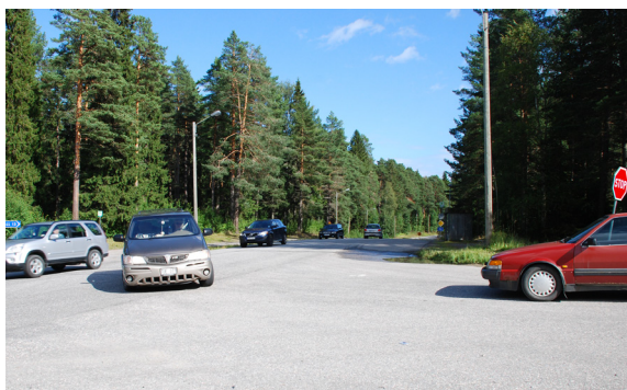
Figur 4.3. Korsningen med väg 629 saknar vänstersvängfält.
