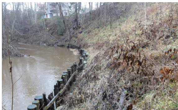
Figur 4.9. Olika typer av åtgärder såsom träpalissader och geonät har utförts vid Sättnån för att förhindra erosion.
