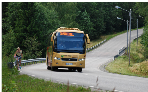
Figur 4.5. Vägen saknar väggen och utrymmet för oskyddade trafikanter är litet. De snäva kurvorna skapar siktproblem och omöjliggör omkörningar.
