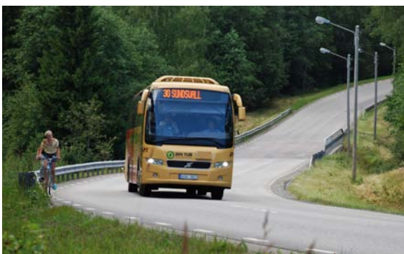
Figur 4.5. Vägen saknar vägren och utrymmet för oskyddade trafikanter är litet. De snäva kurvorna skapar siktproblem och omöjliggör omkörningar.
