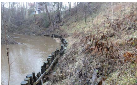
Figur 4.9. Olika typer av åtgärder såsom träpalissader och geonät har utförts vid Sättnån för att förhindra erosion.
