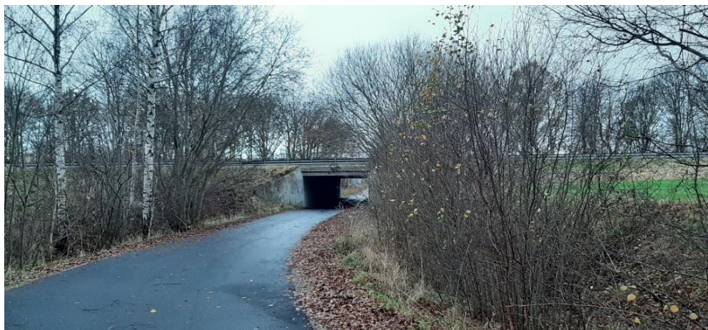
Figur 11. Befintlig bro över gång- och cykelväg i trafikplats Helsingborg södra.
