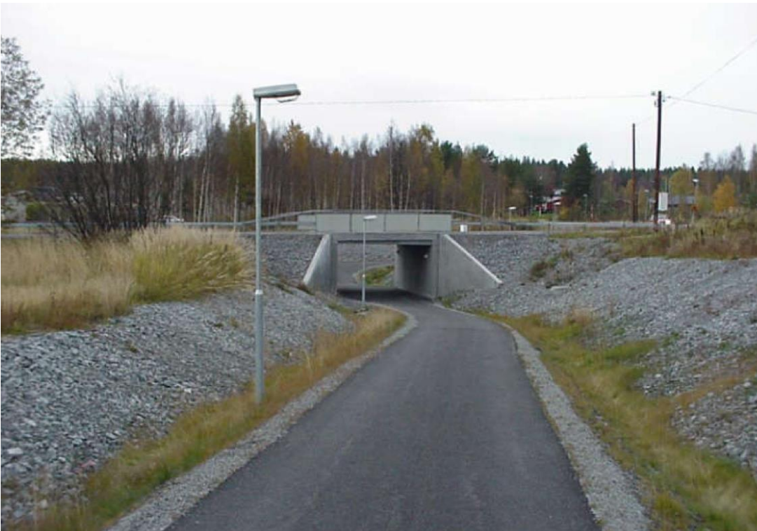
Figur 19 Exempelbild på GC-tunnel. Exemplet visar tunnel under väg. Förslaget innehåller GC-tunnel under järnväg, utformning kommer beslutas i bygghandlingsskede. Bild Trafikverket.
