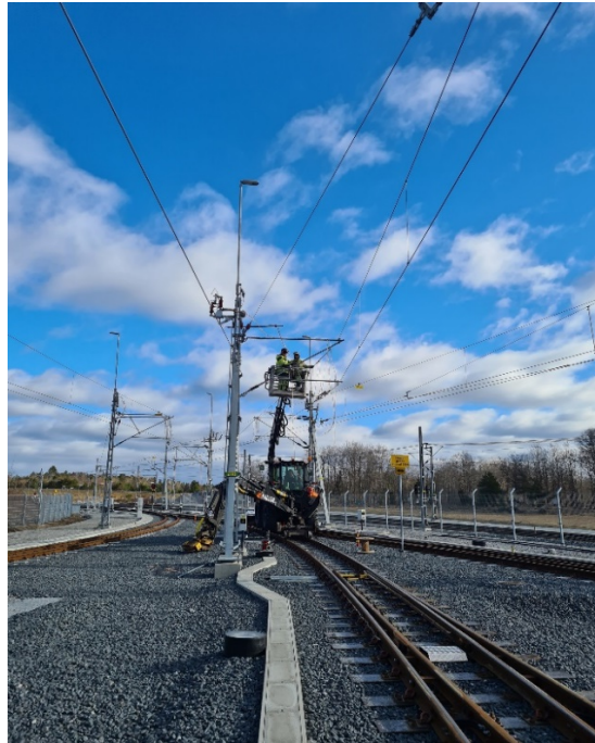
Figur 10 och 11. Exempel på hur kontaktledningsbyggnation går till. Bilden till vänster visar anläggande av grävt fundament. Bilden till höger visar hur man drar kontaktledning. Arbetena bedrivs från spåret. Foto: Jonas Berglind.
