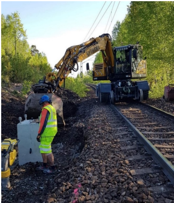
Figur 10 och 11. Exempel på hur kontaktledningsbyggnation går till. Bilden till vänster visar anläggande av grävt fundament. Bilden till höger visar hur man drar kontaktledning. Arbetena bedrivs från spåret. Foto: Jonas Berglind.
