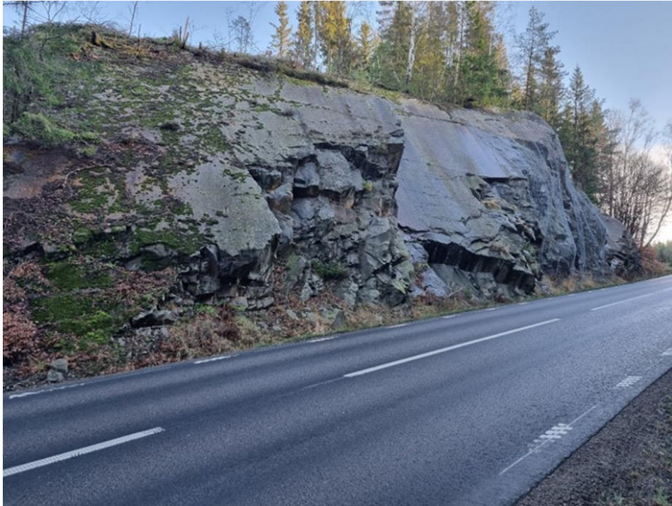
Figur 19 Sektion 1/115 – 1/220, Stor bergskärning delvis förstärkt med nät. Foto taget åt nordost)
