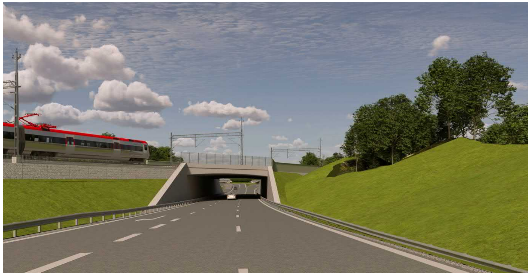
Figur 57. Illustration av järnvägsbro över Hamnleden sett mot öster.
