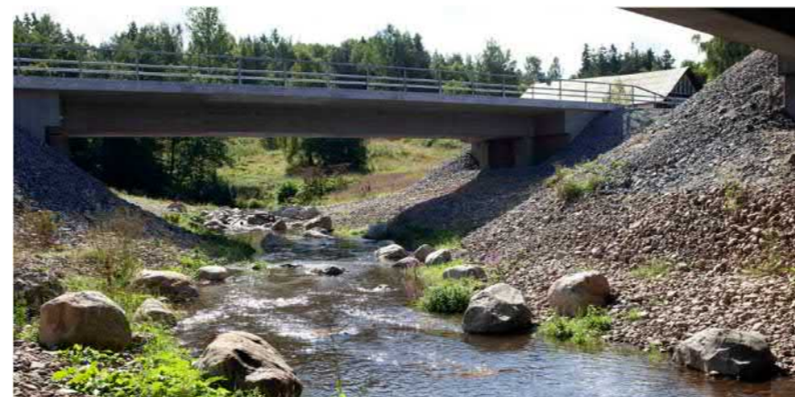
Figur 44. Exempel på omgestaltat vattendrag med konstgjord åfåra under väg 73. Här hade det varit önskvärt att täcka makadamslänterna med naturligt bildad jord. Foto: Trafikverket.
