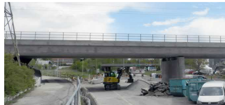
Figur 16. Inspirationsbild på järnvägsbro med rundad undersida, framträdande kantbalk och skivstöd med rundade kortsidor.
