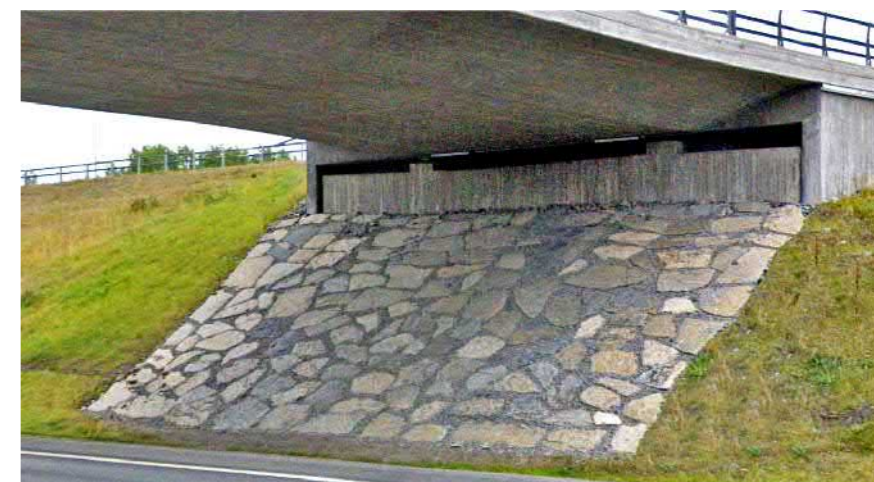
Figur 20. Exempel på ordnad stensättning på slänt under bro.
