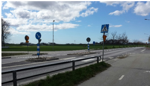
Figur 16 Passage vid Hökvägen/Kyrkstigen, vy mot väster.
