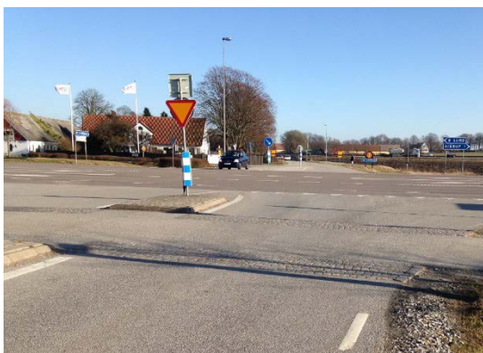
Figur 15 Passage Väståkravägen, vy mot väg 852.
