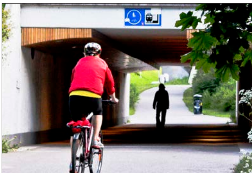
Figur 16. Exempel på gång- och cykeltunnel.
