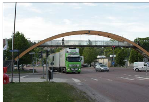
Figur 17. Exempel på gångbro, E4 Sundsvall.
