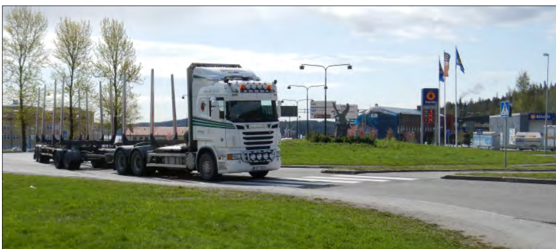
Figur 45. I Paradisrondellen finns risk för vältningsolyckor.
