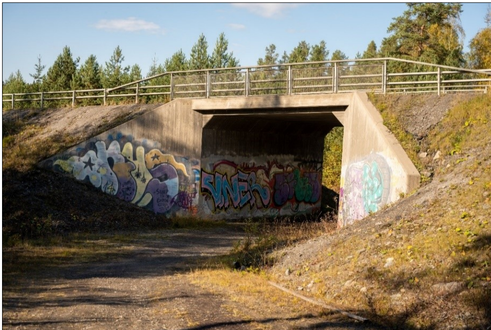
Figur 14 - Bro 1020. Foto från vägens södra sida mot väster.
