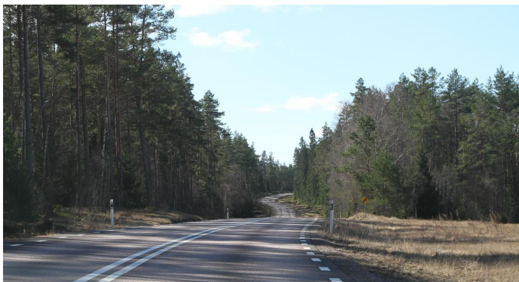
Bild 6 Väg 63 Vy mot öster där tidigare kurvjusteringar genomförts
