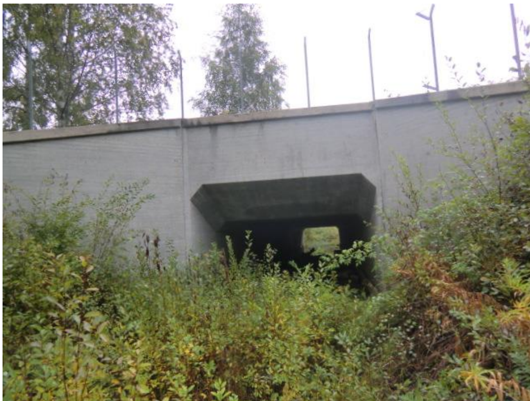
Bild 5. Bro över Flottningsrännan, NV Granvåg i Sollefteå (22-724-1).
