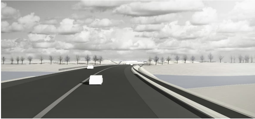
Figur 29. Håkanstorsbron över ny E65 sett från väster.
