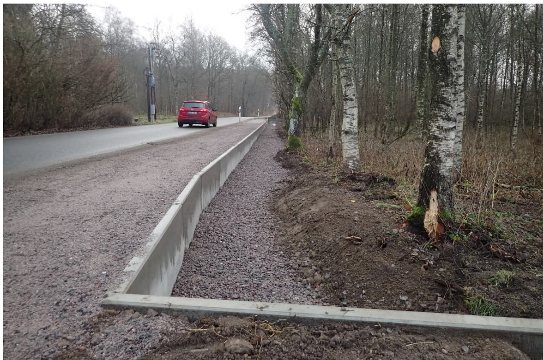
Figur 77. Bilden visar hur en groddjursbarriär kan se ut. Foto: Per Nyström, Ekoll AB.
