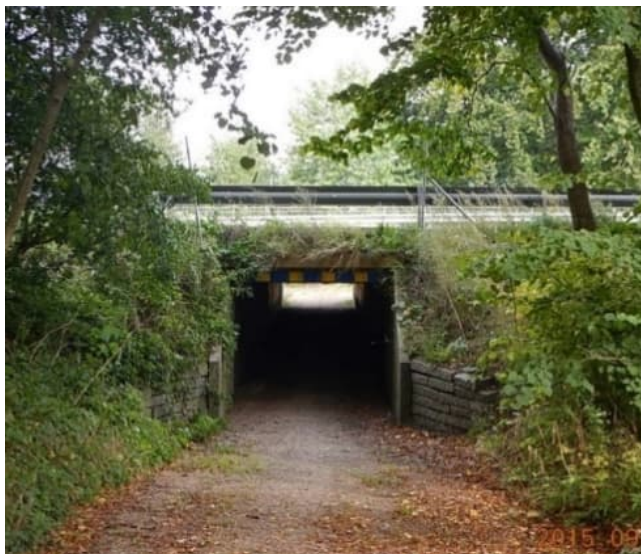
Figur 19. Befintlig vägbro, 12-1196-1, över gångväg.
