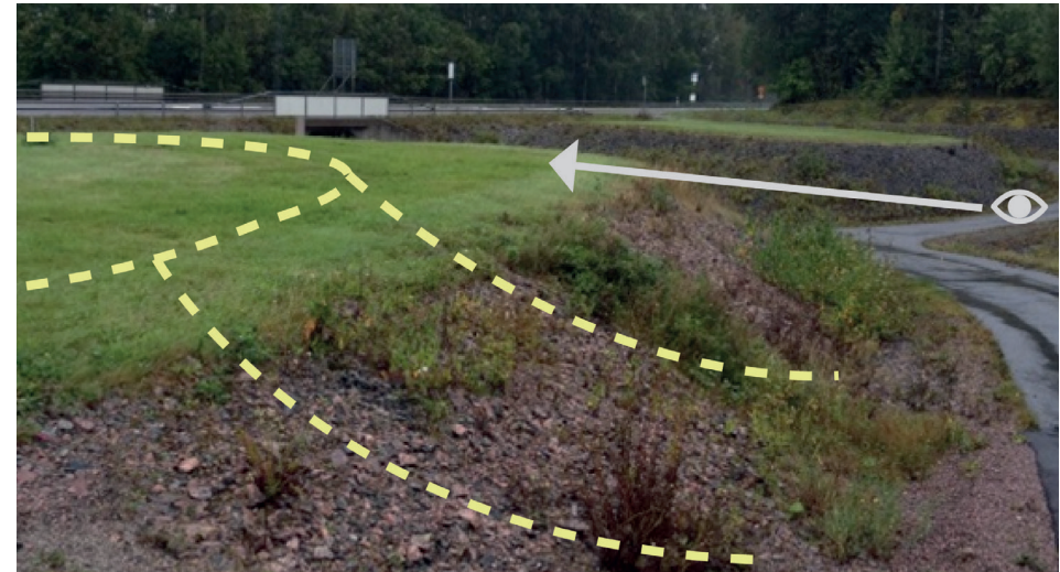
Figur 4.8.3-2 Marken och de branta slänterna skymmer sikten mot befintlig GC-port.
