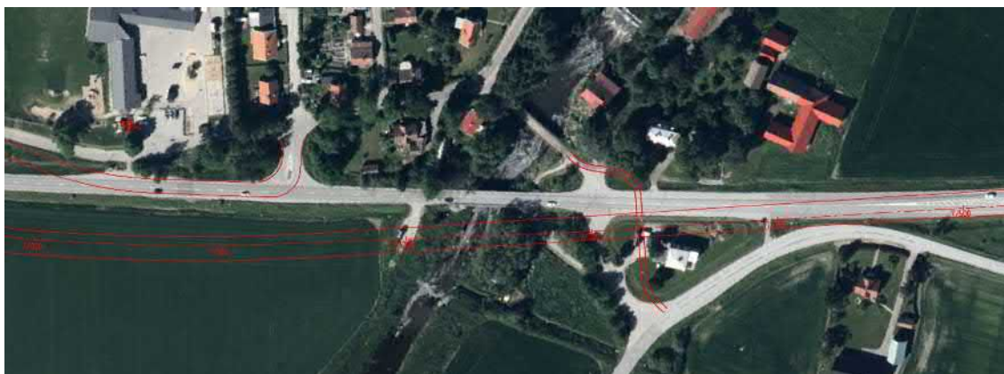
Bild 15. Breddning av Väg 51, km 7/000-7/500.
