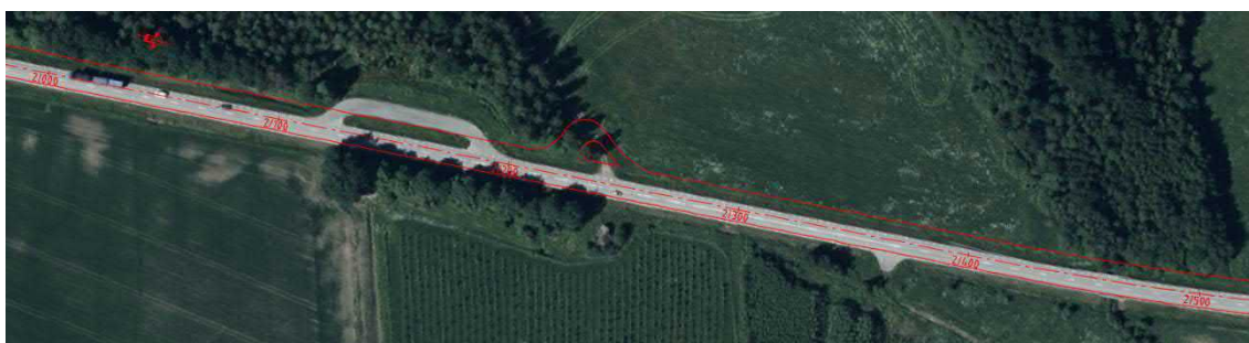
Bild 5. Breddning av Väg 51, km 2/000-2/500.
