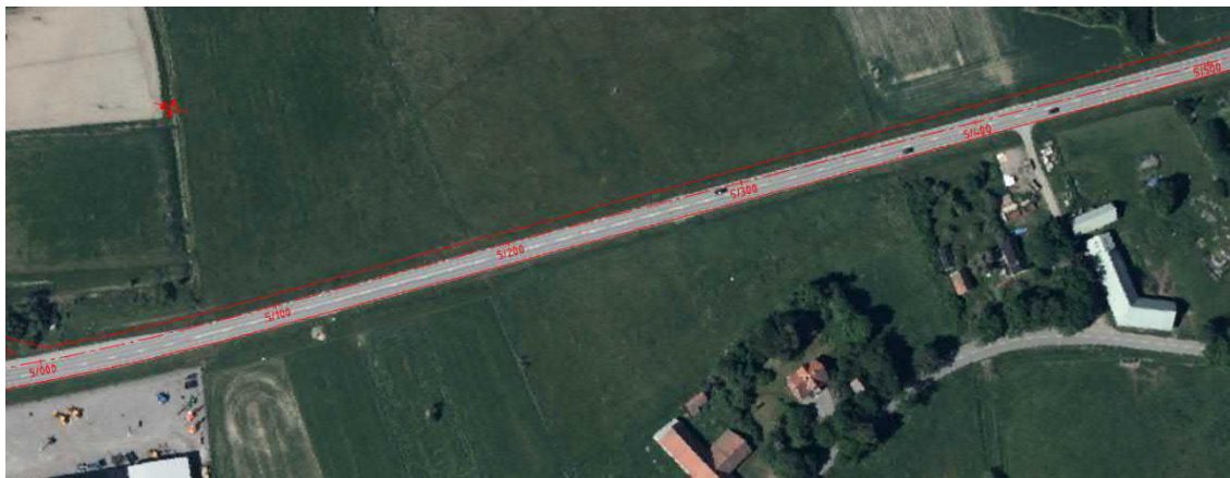
Bild 11. Breddning av Väg 51, km 5/000-5/500.
