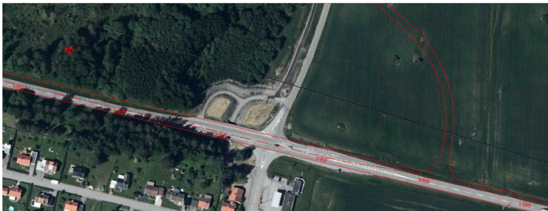
Bild 8. Breddning av Väg 51, km 3/500-4/000.
