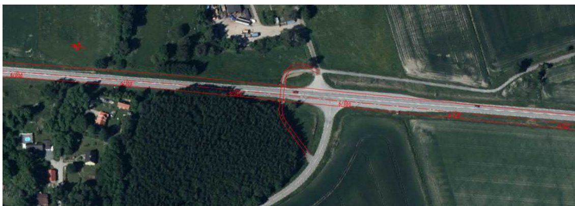
Bild 13. Breddning av Väg 51, km 6/000-6/500.
