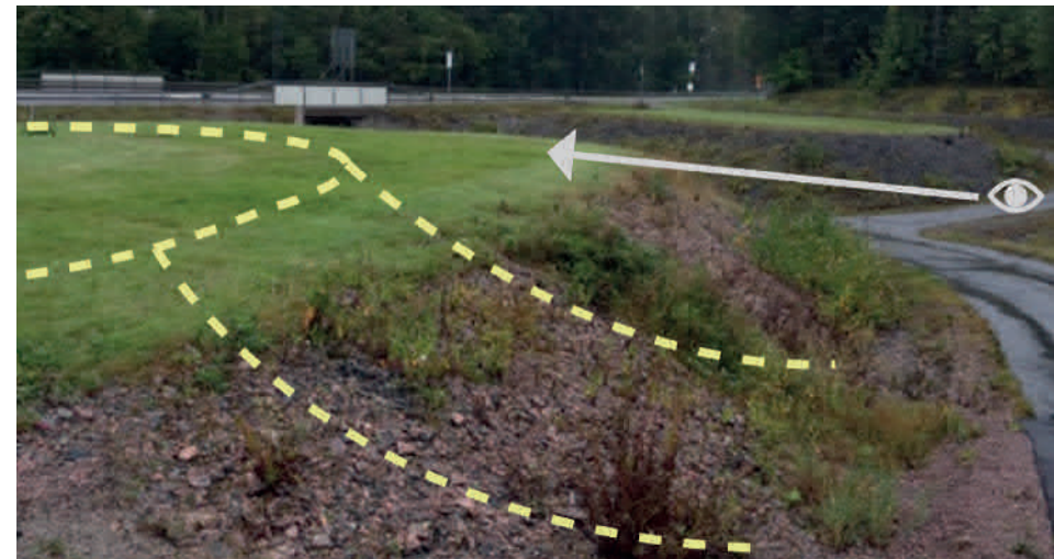
Figur 4.8.3-2 Marken och de branta slänterna skymmer sikten mot befintlig GC-port.
