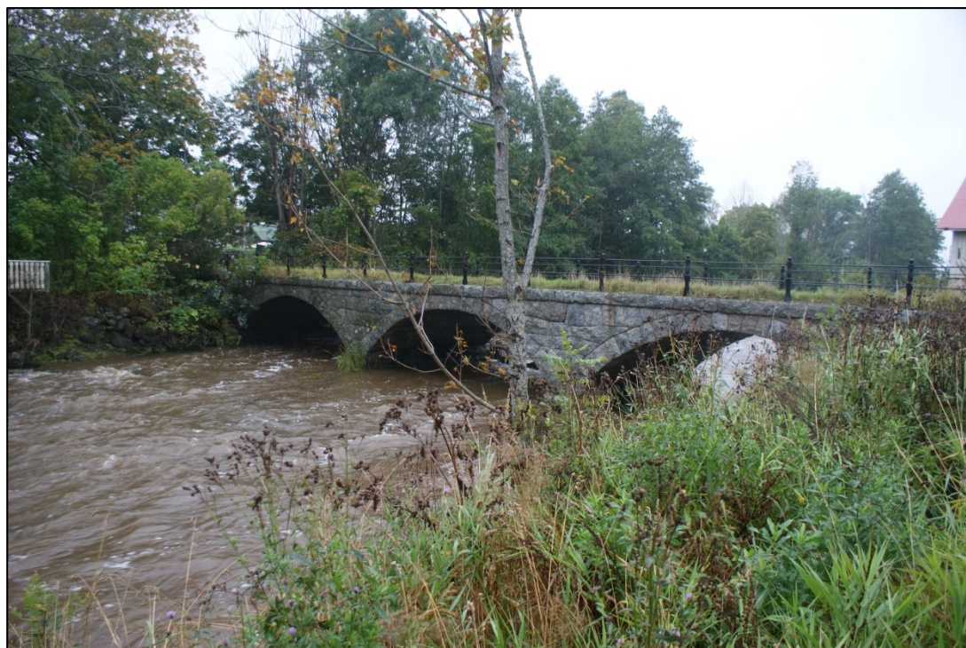
Figur 13 Stenvalvsbron över Täljeån.
