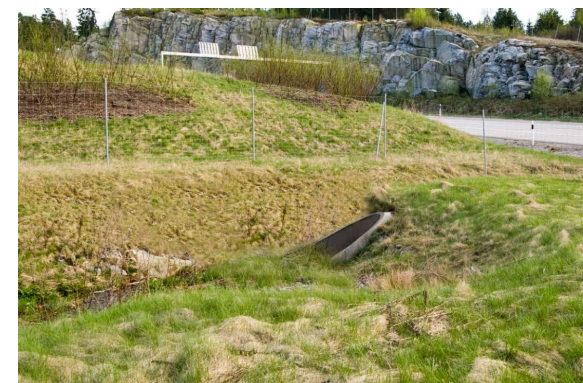
Figur 12. Exempel på snedkapning av vägtrumma. Vägbilder Trafikverket.
