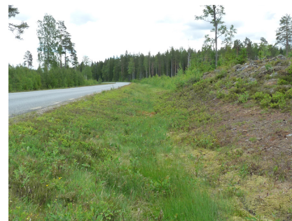
Figur. 14. Exempel jordslänt med markvegetation i skogsmiljö. Vägbilder. Trafikverket.
