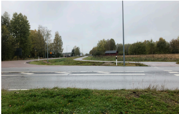
Figur 10. Gång och cykelväg från korsningen vid Oti som förbinder sträckan till Fagersta.
