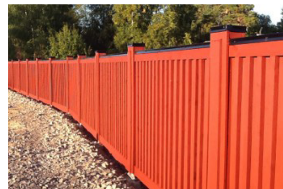
Figur 18. Exempel på bullerskyddsskärm i trä med stående locklistpanel, accentuerade stolpar och plåtavtäckning.
