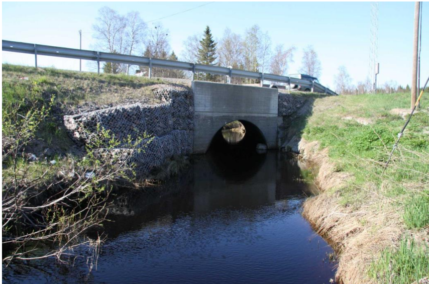
Figur 5 - Krångebäcken passerar under E4 just norr om anslutning B
