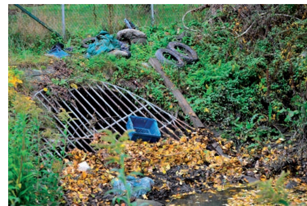
Figur 18. Bällstaån då den rinner in i kulvert vid Fristadsvägen.
