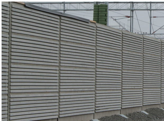
Figur 20. Utsida på bullerskyddsskärm från tidigare etapp utmed Mälarbanan (Barkarby-Kallhäll)
