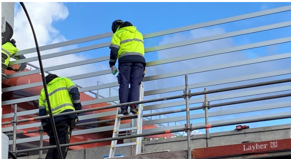
Figur 4. Montering av dammskydd vid omformarstation (Foto: Patrik Johansen).
