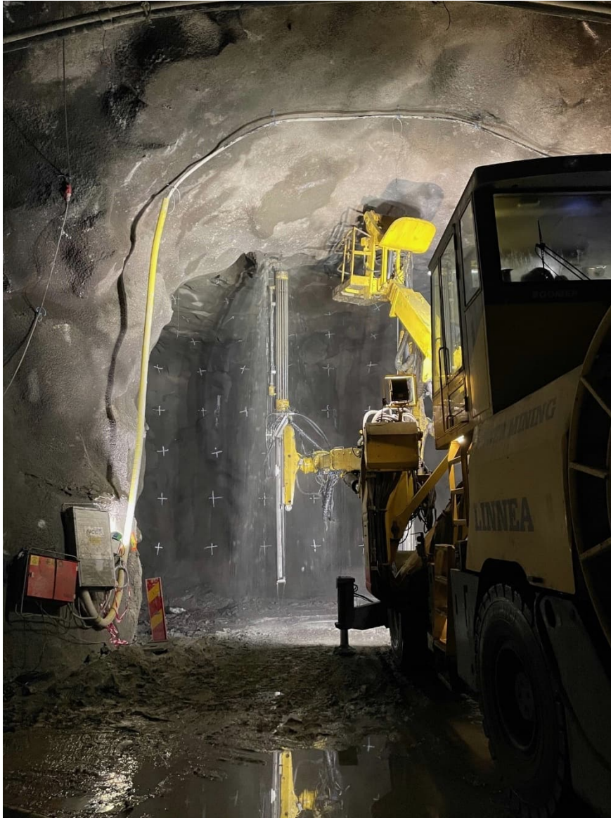
Figur 2. Borrning i berg med tillsatt vatten. (Foto: Emma Agfjord).
