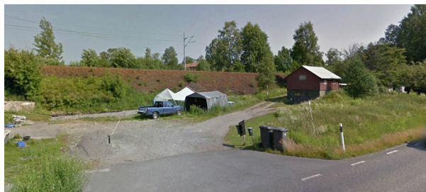
Befintlig banvall med krossmaterial.
