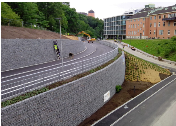
Exempel på gabionmur i vägmiljö. Överkant följer vägprofil.
