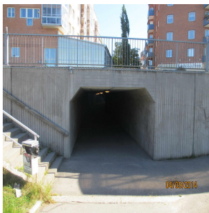
Figur 6 Bro 20-872-1 gång-och cykelväg vid Carlavägen Ludvika, km 3/730.
