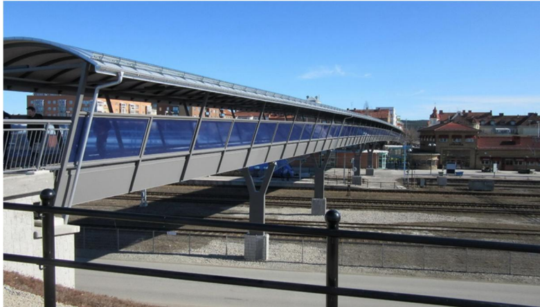
Figur 8. Bro 20-1373-1, gång- och cykelbro, km 5/620.
