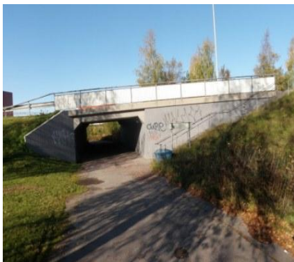
Figur 6 Bro 20-869-1 gång- och cykelväg km 4/600.
