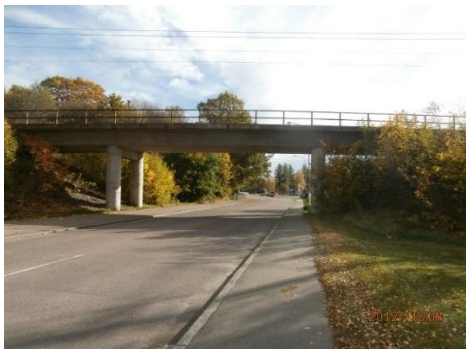
Figur 7 Bro 3500-3308-1 över kommunal gata Gonäsvägen.
