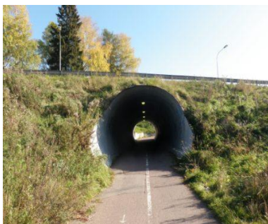
Figur 8 Bro 20-1340-1 över gång- och cykelväg N Lärkvägen Ludvika, km 3/270.
