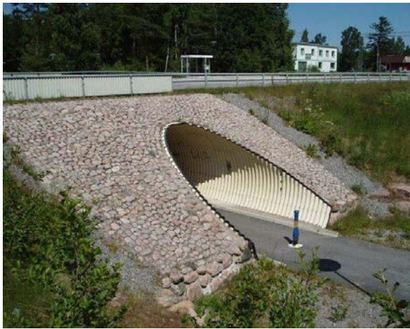
Rörbro över GC-väg vid Lugnås
