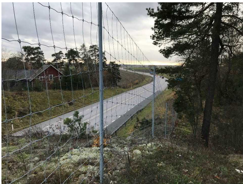
Figur 6. Vägsärningen sydost om Jättadansen. Vy mot sydväst.
