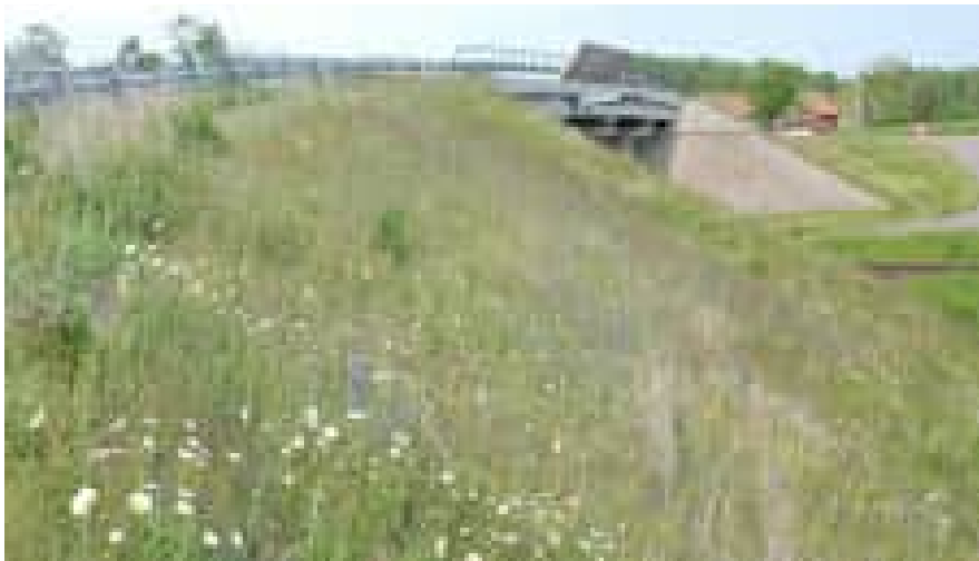
Figur 16. Genom att täcka sidområden med avbaningsmassor från platsen kan en naturlig flora snabbt etableras. Med regelbunden slåtter kan man skapa blommande vägkanter. Källa: Trafikverket, 2015.
