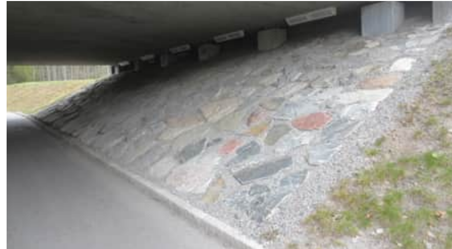
Figur 45. Släntbegräddning av stenblock under bro.
