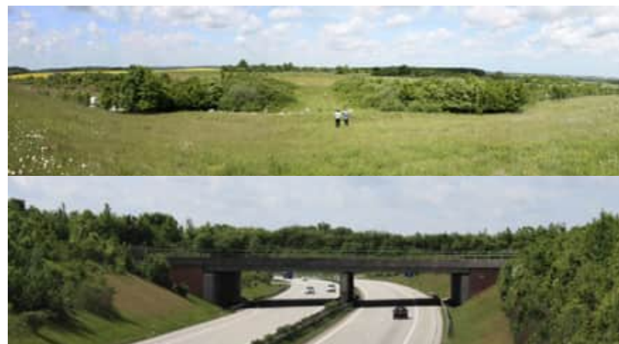
Figur 40. Exempel på ekodukt ur Trafikverkets rapport Effektiv utformning av ekodukter och faunabroar. "Naturlig passage över väg A20 vid Barnekow i norra Tyskland (övre fotot) och samma passage från väg A20 (undre fotot). Notera den fria sikten rakt över ekodukten och dess buskiga sidor som visar vägen för viltet. Foto: Erik Jondelius (SLU)."
