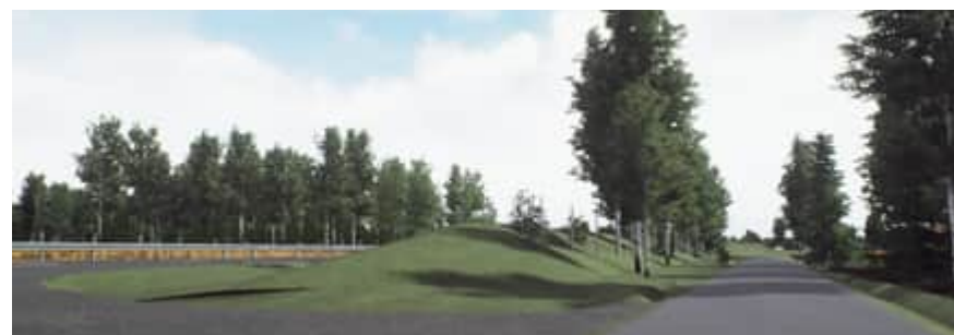
Figur 32. Parallellt med trädgårdarna planteras träd och buskar på bullerskyddsvallens krön och bakslänt. En meters friutrymme på vardera sida faunastängslet ska hållas för skötseln. Mer exakt placering av faunastängsel och planteringar görs i byggskede.
