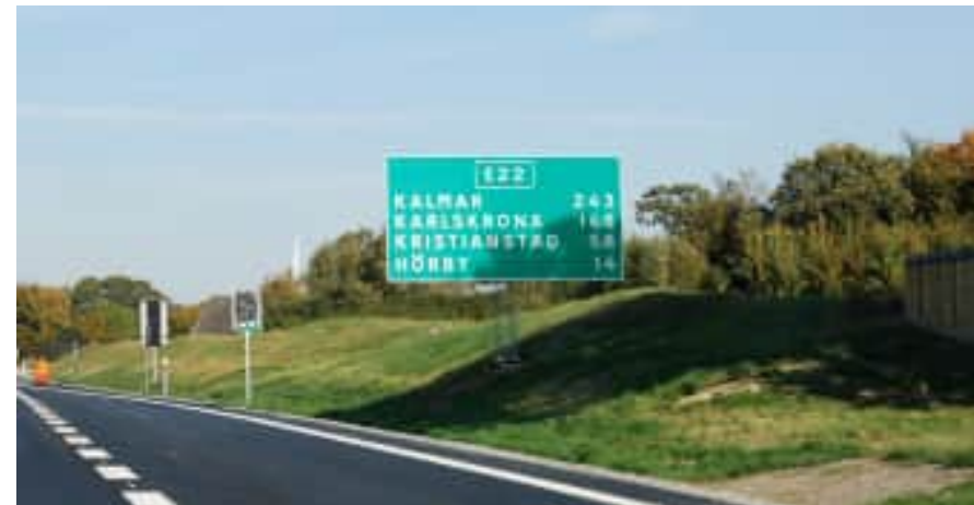
Figur 17. Skärm och vall i mosaiklandskap, där vallens form anpassats till omgivningen. Variation i höjd och sidled minskar intrycket av "limpa". Från E22 i Skåne. Källa: Trafikverket, 2015.
