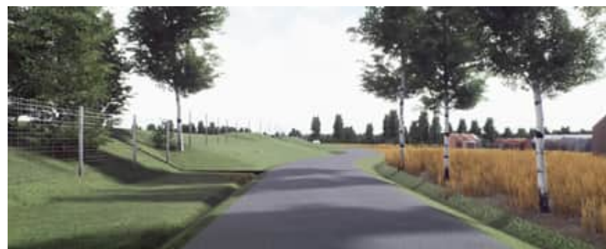
Figur 33. Planteringen av bullerskyddsvallens bakslänt övergår i en landskapsanpassning av topografin som bryter av den långa och raka strukturen av bullerskyddsvallen sett från parallellvägen. Parallellvägen tar stöd i denna höjdformation där den viker av söderut.
