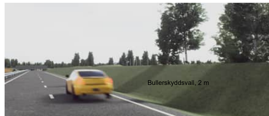
Figur 30. Den cirka två meter höga bullerskyddsvallen täcker för en trafikant det mesta av utsikten söderut från Sjövik och fram till ekodukten. Över vallen kan vegetation och ett par kullar ses. I änden av vallen ses en ekodukt som ser ut att ansluta mot en naturlig höjd på ömse sidor av vägen. Tanken med dessa landskapsanpassningar sedda från vägen är att de ska ge en indikation på det småskaliga landskap som finns på andra sidan vallen.
