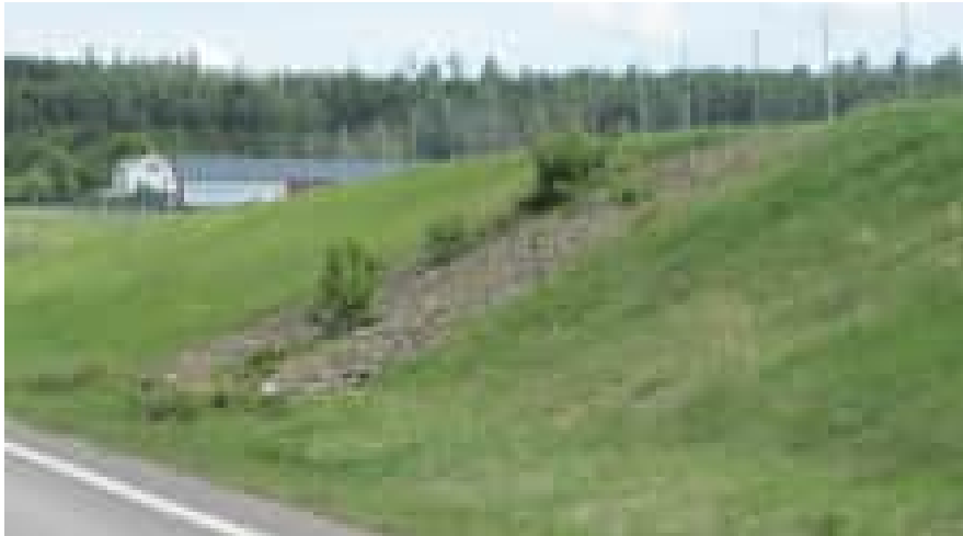
Figur 15. Jordklädda och grässa ytor i sidområdet motverkar slyuppslag, till skillnad från ytor med grovt krossmaterial där endast sly kan gro. Källa: Trafikverket, 2015.
