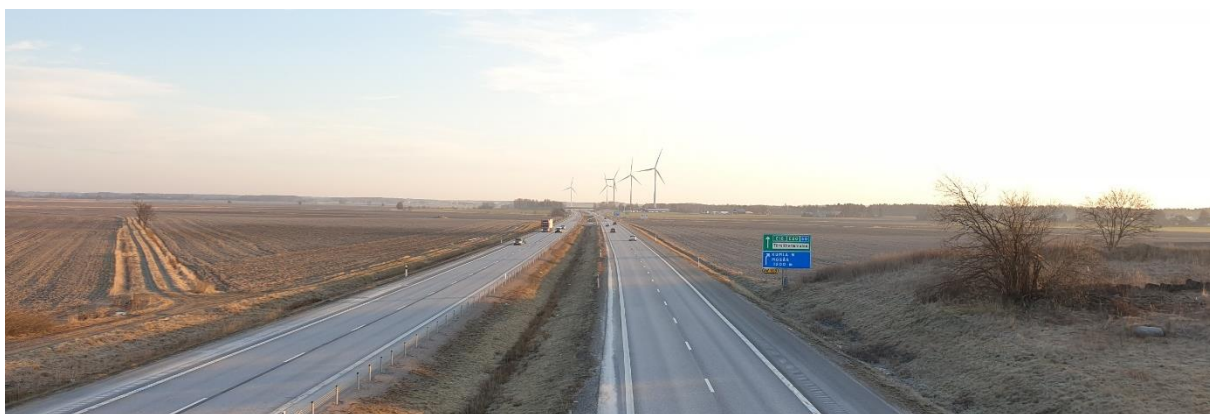
Figur 2. E20 norrgående strax före avfart 108 mot Kumla. Källa WSP
