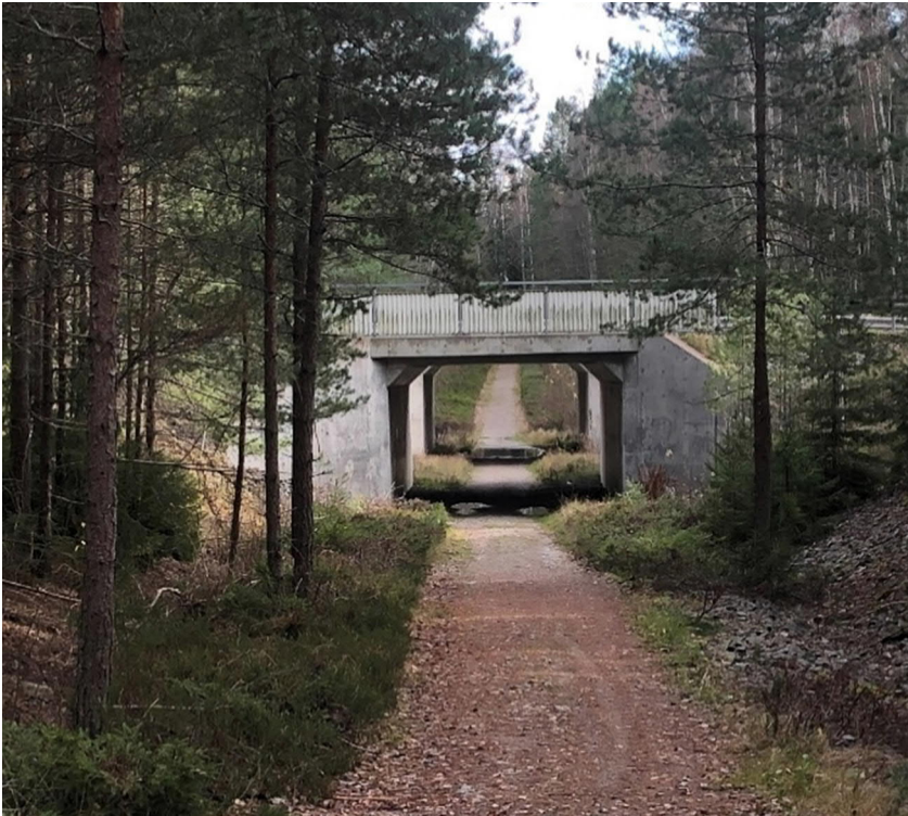
Figur 18. Tunnel under E20 norr om Åbytorp som möjliggör för boende på östra sidan av E20 ta sig till Steneskogen.
