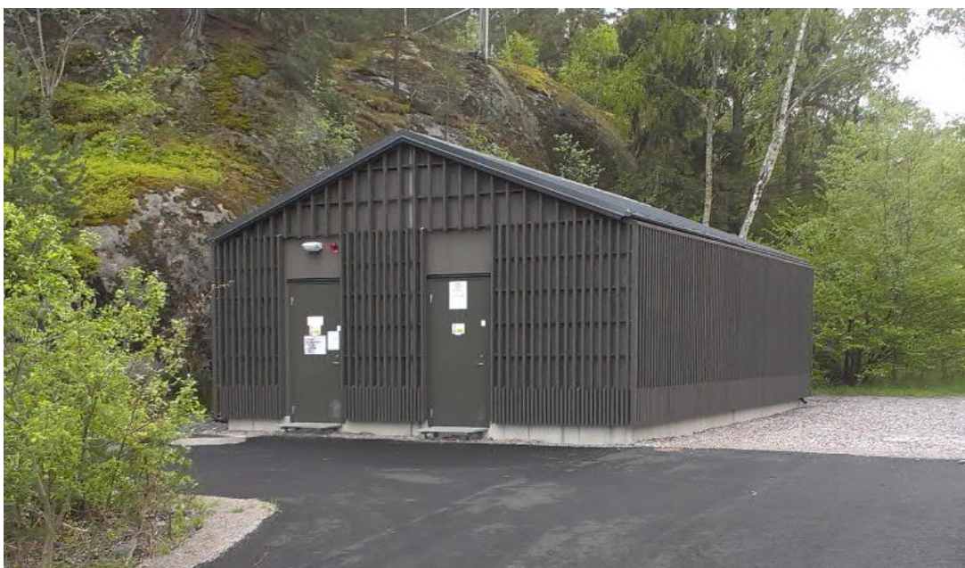
Figur 19. Teknikhus längs Lidingöbanan. Fasaden är beklädd med ett vertikalt raster. Den mörka kulören smälter fint in i bergs- och skogsmiljön.
