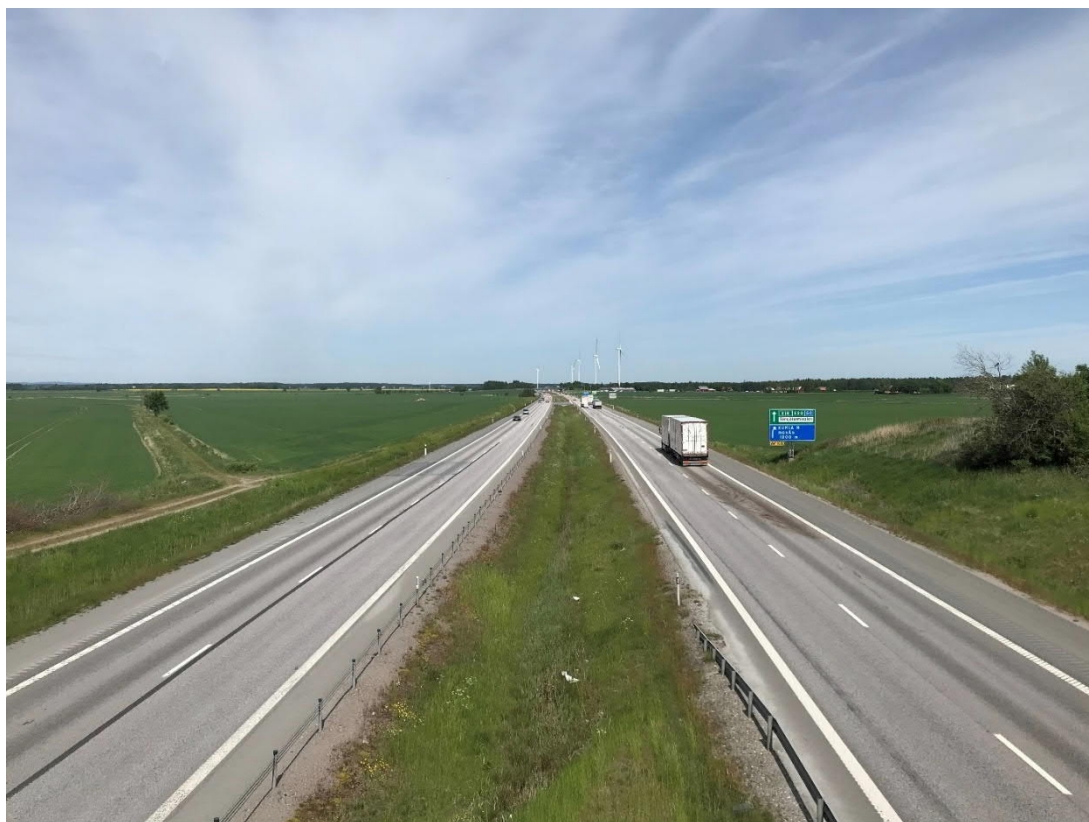
Figur 4. På sträckan har E20 två körfält i vardera riktningen. Foto taget mot norr, från bro där väg 542 går över E20.
