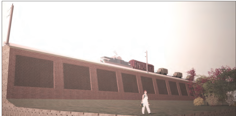
Figur 4.2:8: Principiell utformning av järnvägsbank för enkelspår byggd av mur, inklädd i fasadtegel, bankhöjd 11 m, murlutning 5:1. Tegelfasaden kan ge effekten att banken lättare inordnas i närmiljön som är präglad av industrianläggningar med olika ålder.
