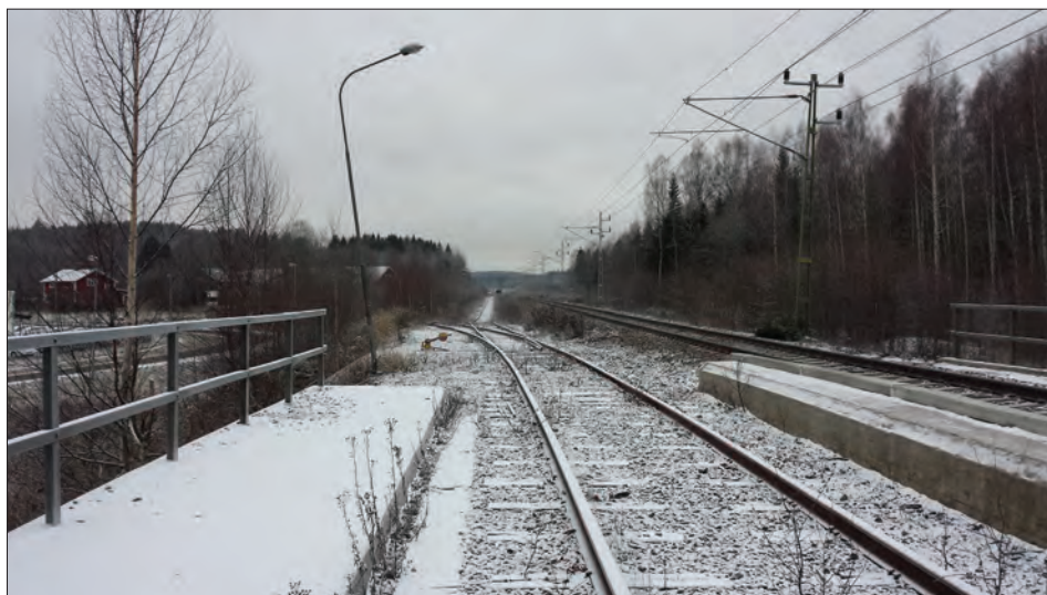
Figur 4.2:4 UA1 + Etapp 2 viker av norrut (åt höger i bilden) strax väster om befintlig bro över Timmervägen.
