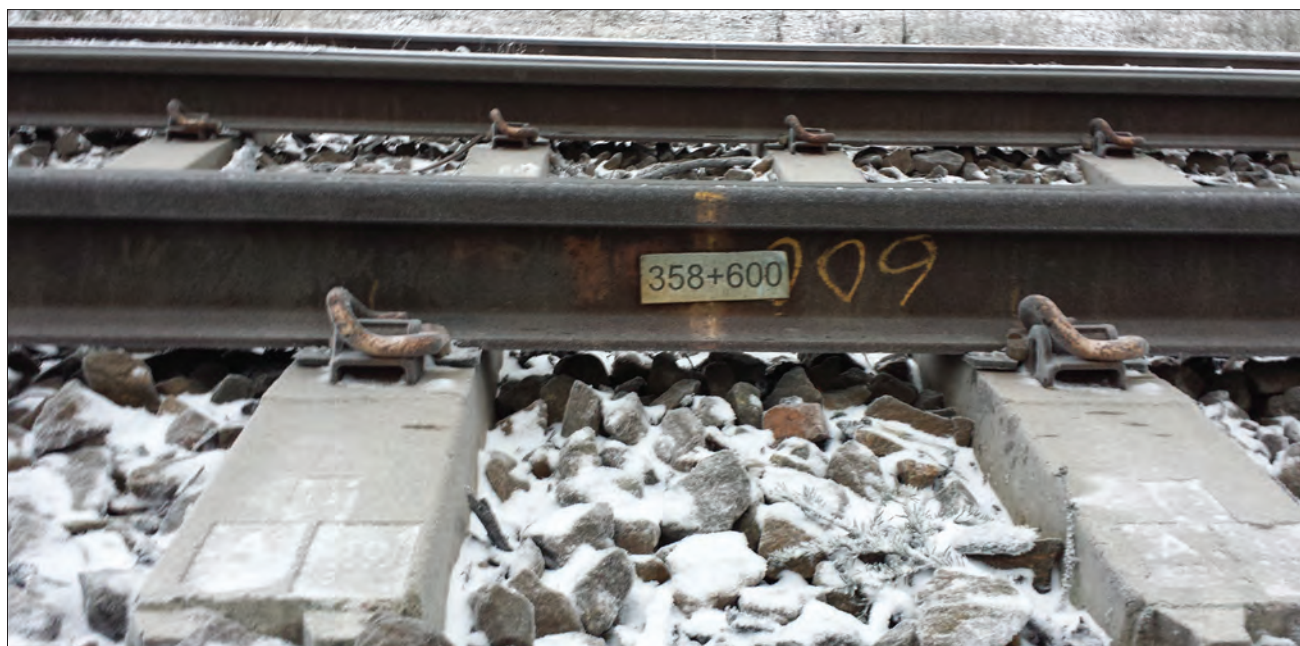
Figur 3:1 Befintlig Ådalsbana strax öster om Birsta mötesstation
