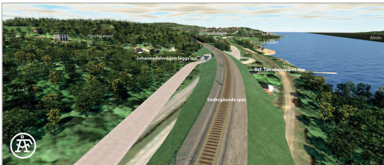
Figur 7.3:4 Maland A - Skärning, bank över Johannedalsvägen, vy mot norr. Bankhöjden som mest tio meter, norr om vägporten. Vy nr 2 genererad ur samrådsmodell.
