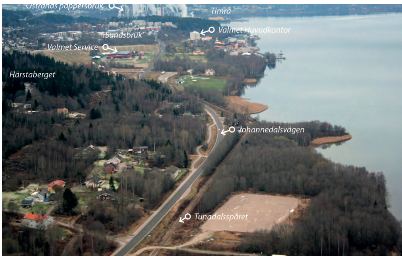
Figur 4.2:6 Snedbild 4. Utredningsområdet sett söderifrån. Tunadalsspåret mitt i bild, bostadsområdet Berghemsvägen nedanför Härstabergets östslutning till vänster. Malandsbadet i bildens mitt, där Tunadalsspåret gör en S-kurva. Strandzonen mot Alnösundet söder om badet är den enda kvarvarande som har naturlig strandlinje. Källa: Trafikverket.
