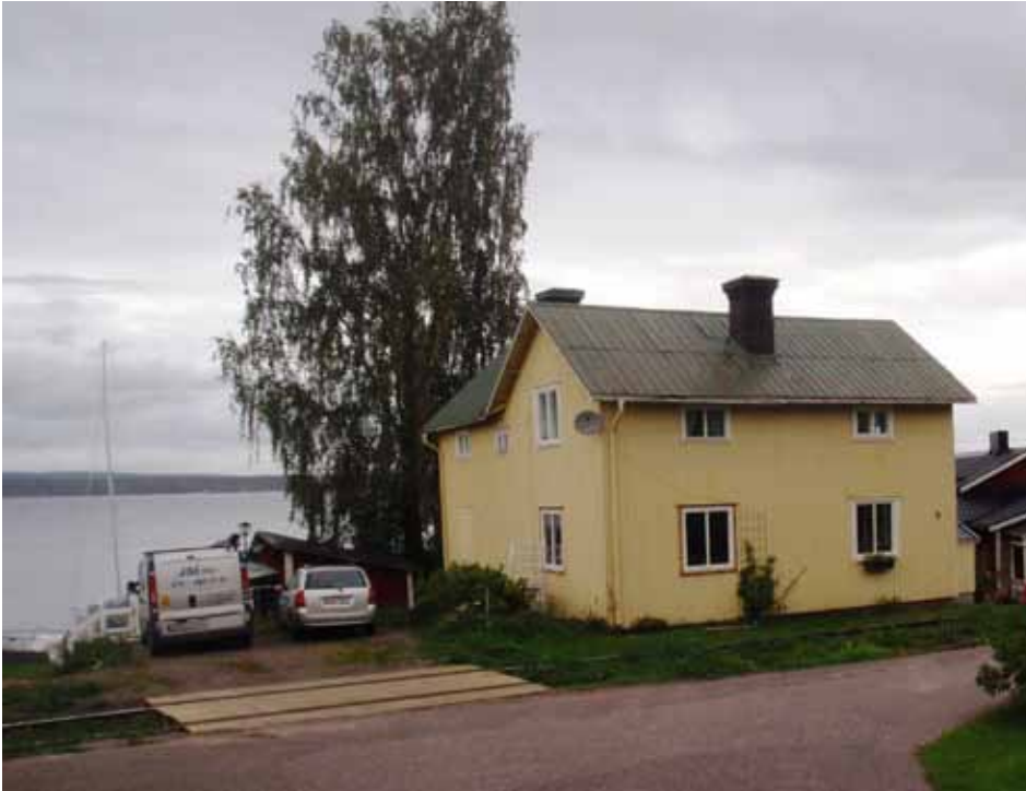
Figur 6.8. Befintlig Tunadalssbana passerar nära bostadshus vid Flodbergsudden.
