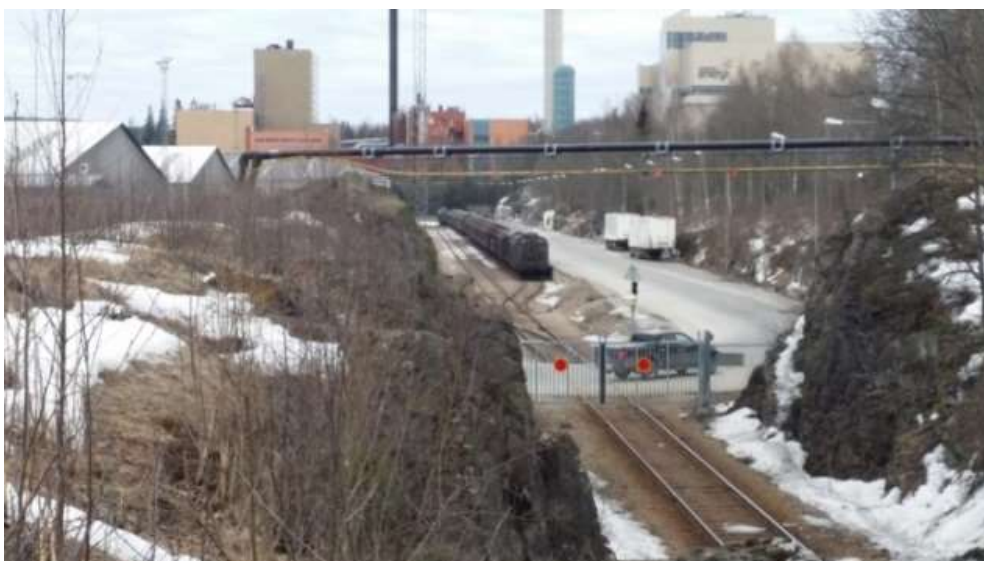
Figur 2.5:3 Tunadalsspåret vid grindarna till Tunadalshamnen.
