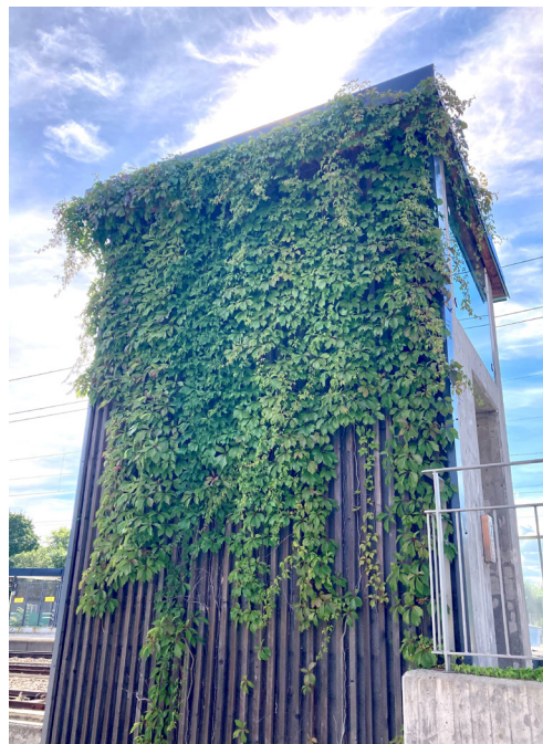
Figur 31. Hiss med vägg klädd med träribbor, bevuxen med klängande växter. Exempel från Knivsta station.
