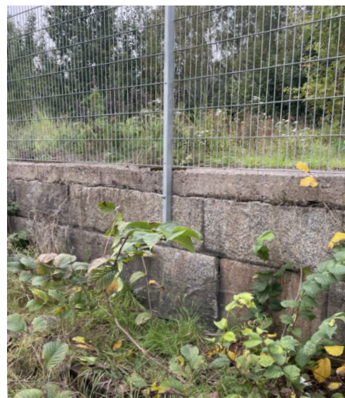
Figur 19. Granitsten som tidigare utgjort mur till plattformar, återanvänds
