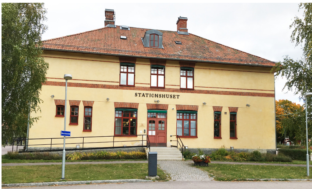
Figur 8. Trappa och ramp, med handledare, leder upp till Stationsbyggnaden mot Stationsvägen.
