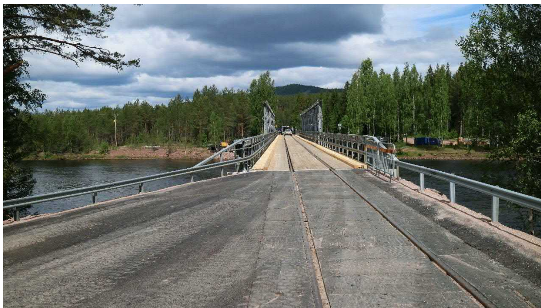
Figur 4 - Bild på ersättningsbron. Källa: Trafikverket.
