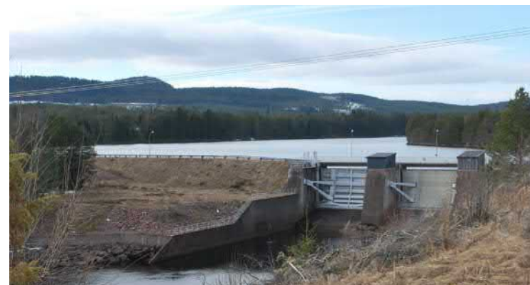
Blybergsdammen norr om vägplanområdet är ett storskaligt element i landskapet.
