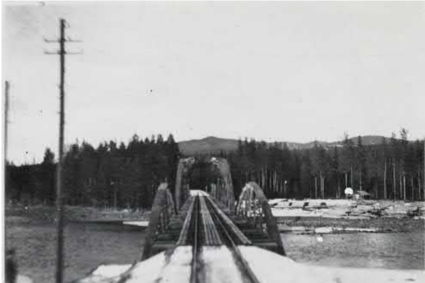
På bilden från 1930 syns till höger om bron timmerupplaget intill brofästets norra sida. Idag utgörs platsen av en rastplats med slogbod samt grillplats. Källa: Samlingsportalen.se. Jvm.KDAH00342.
